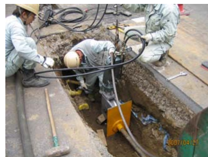
トリックトレンチレス施工状況
