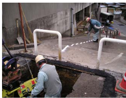
フレックスドリル施工状況①
