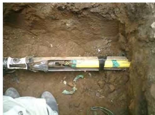
写真-9 PE管引入状況
