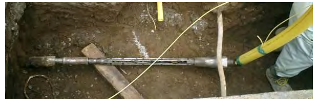
写真-6 カッター設置状況
