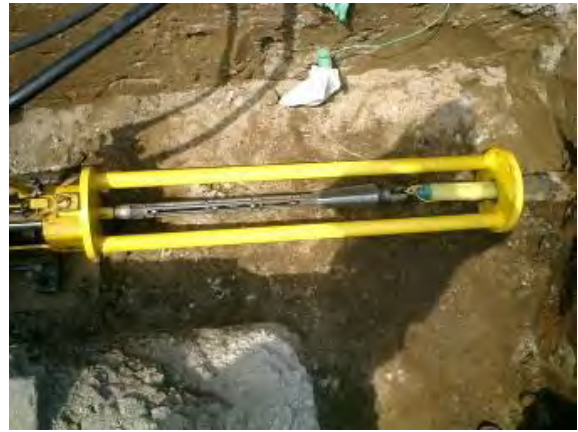
写真-17 カッター引き込み完了
