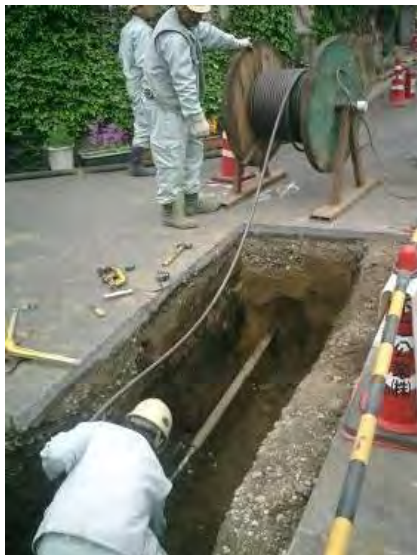
写真-5 ワイヤー挿入状況
