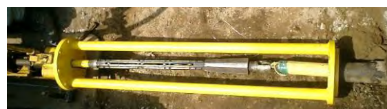
写真-12 カッターが納まる空間
