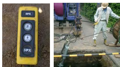
写真-2 リモコン作業
