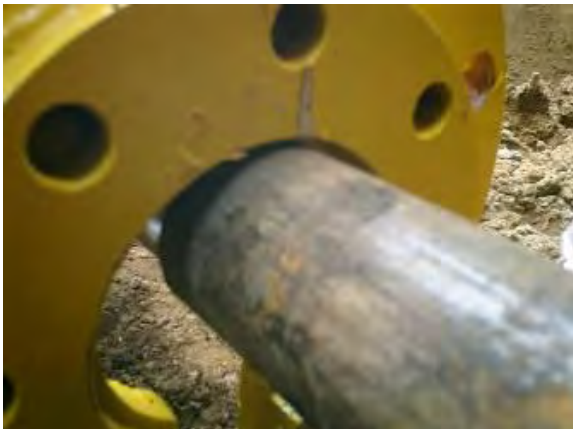
写真-16 拡径断面对応状況
