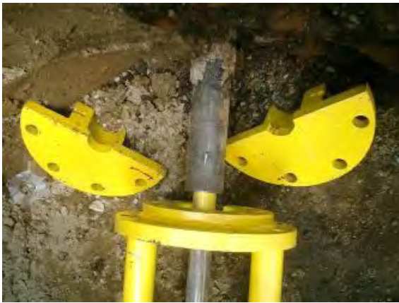
写真-15 円形対応部材取り外し
