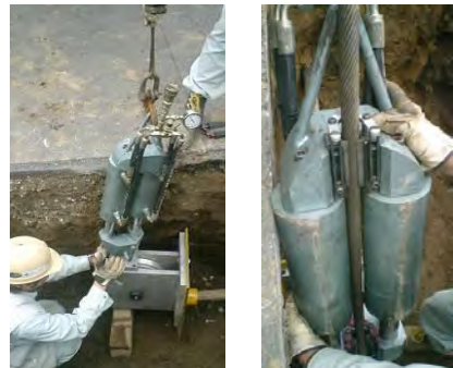
写真-7 本体設置状況
