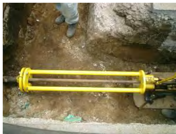
写真-13 回収治具設置
